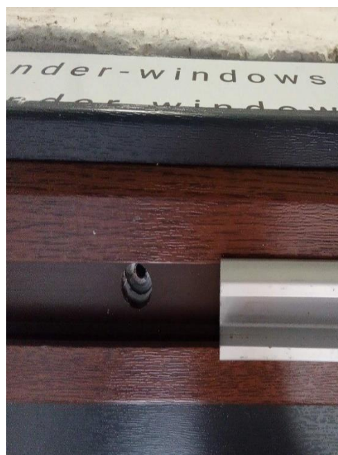
Rys... Otwór na dybel pod górną szyną.
