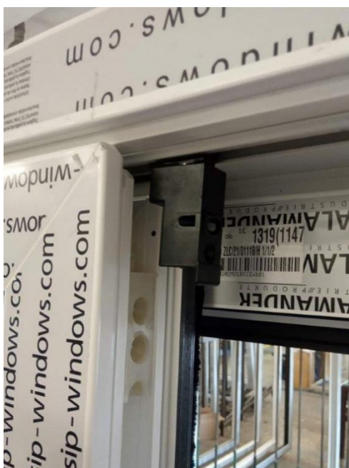
Rys.... Demontaż wieszaka.
