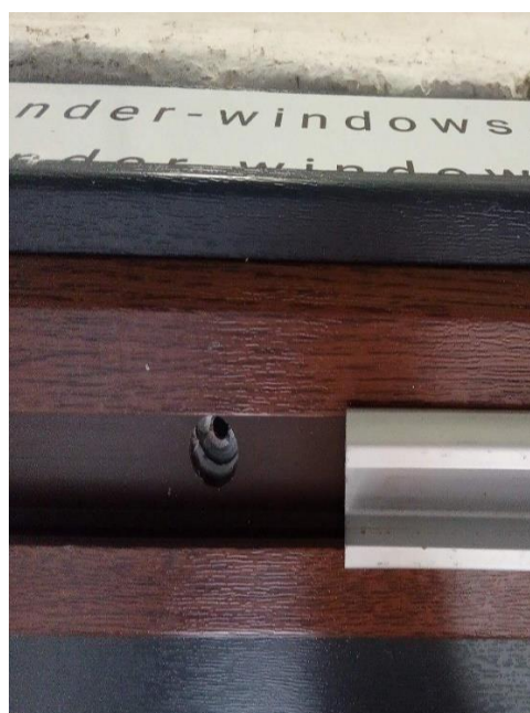
Obr. ... Otvor na hmoždinku pod
